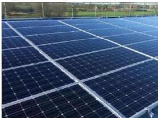
Deutschland Abbau Anlage 577 kWp
