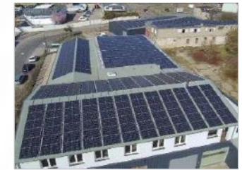
Deutschland Dachfläche in Betrieb 1.06 MWp
