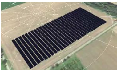
Bayern voraussichtlich 8.327 kWp
