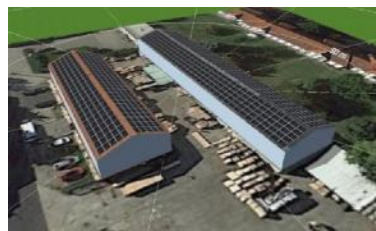
Sachsen voraussichtlich 234 kWp
