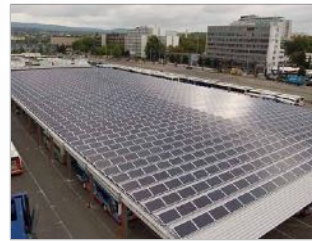
Deutschland Abbau Anlage 405 kWp
